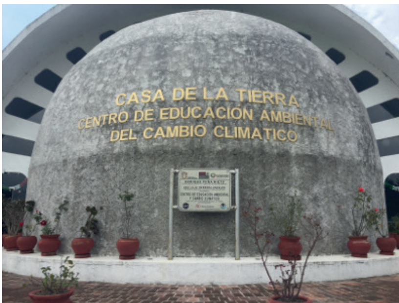
Figura 5.1 Centro de Educación Ambiental y Cambio Climático Metepec, Estado de México
